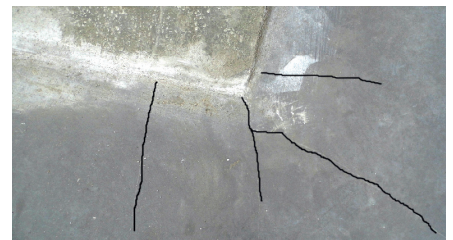
3. ábra Repedések a végelem számítás szerint és a valóságban
